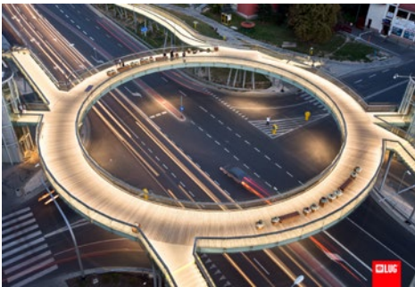
Kładka uliczna, Rzeszów, Polska
