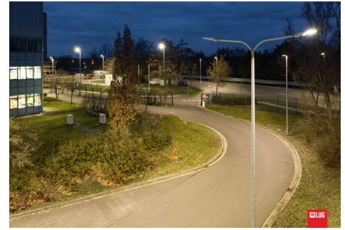
Elektrociepłownia, Cottbus, Niemcy
