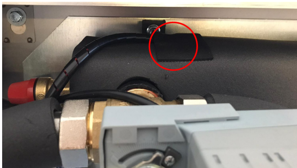
RYŚ. 8. LOKALIZACJA ZABEZPIECZENIA TERMICZNEGO
