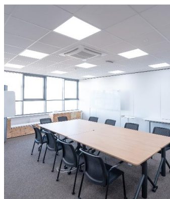
Besprechungsraum mit DALI Licht- und Sensorsteuerung
