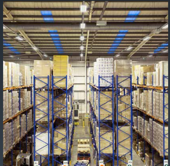
Iluminación eficiente para áreas de logística y almacenamiento – con apertura de luz ovalada para una mejor iluminación de los pasillos.
