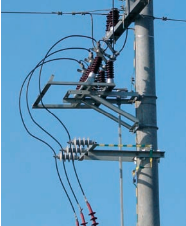
zabezpieczenie kabla SN – zejście z linii napowietrznej
