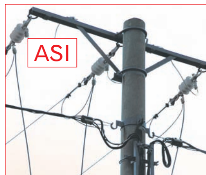
stacja transformatorowa 15/0,4 po modernizacji z zastosowaniem ograniczników ASI
