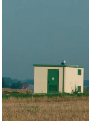
stacja transformatorowa 15/0,4 kV
