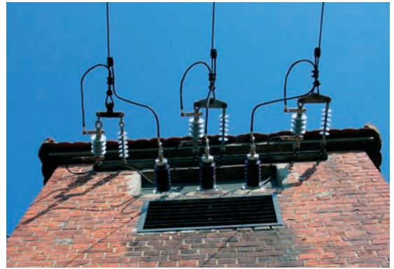
modernizacja stacji transformatorowej – zastosowanie ASI równoległe z izolatorami odciągowymi
