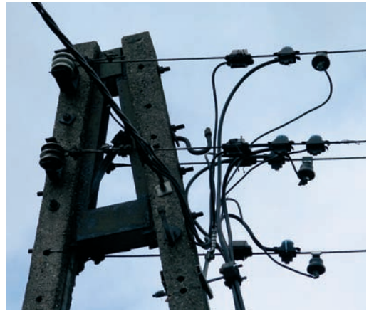
koniec linii napowietrznej nn
