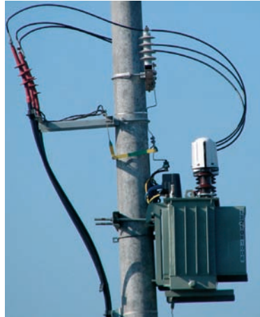
zabezpieczenie uproszczonej stacji transformatorowej 15/0,4 kV
