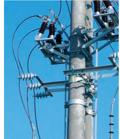
zabezpieczenie kabla SN – zejście z linii napowietrznej
